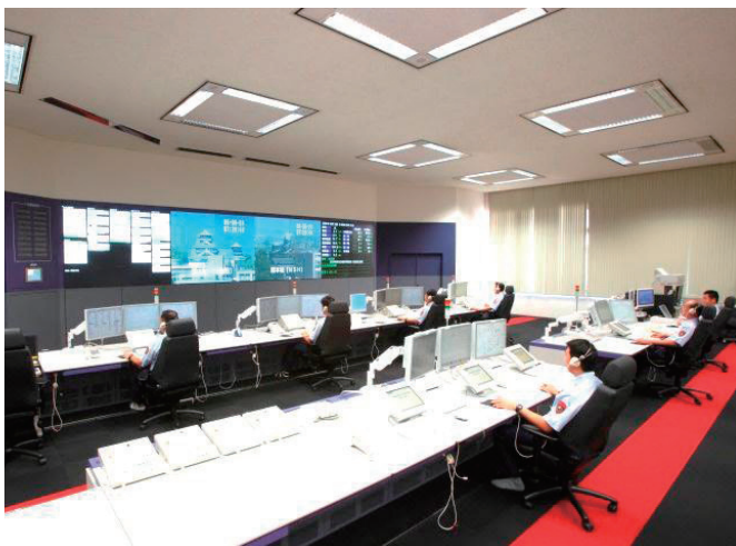
熊本市消防局 司令管制室
